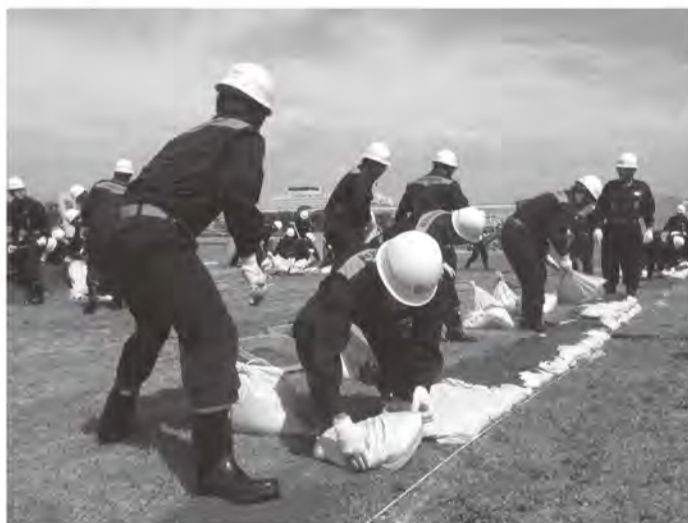
土のうをきれいに並べていきます
