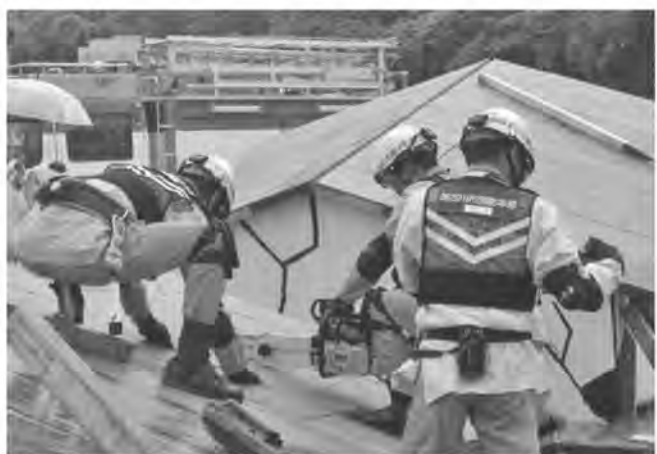
倒壊した家屋からの救出活動
