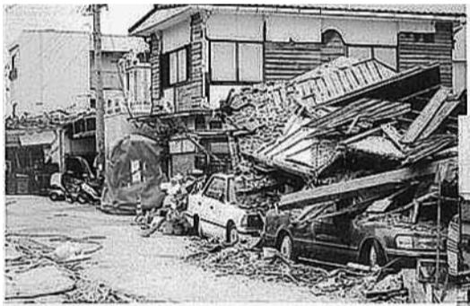
芦屋市内の倒壊家屋現場
