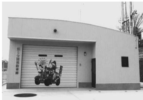
新設された第5分団消防車庫
