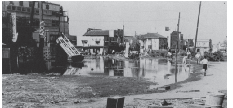
阪神尼崎駅南側の被害状況
