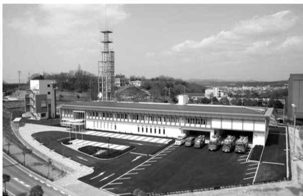
三木市消防本部庁舎
