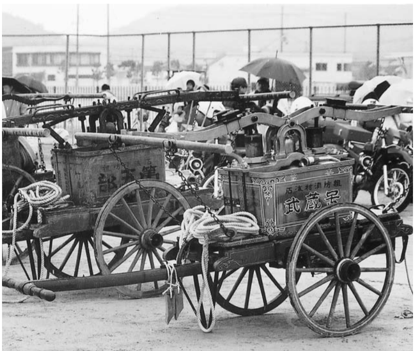
大正期から保存されている腕用ポンプ
