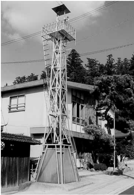
本年撤去された警鐘台
