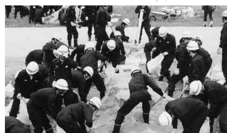
準備工中(土のう作り)
